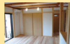
杉フローリングの施工例
